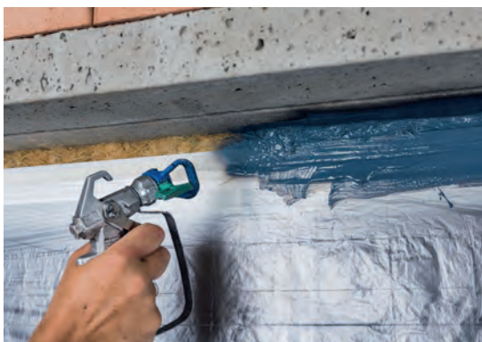
AEROSANA FLEECE Tihendab kuni 70 mm läbimõõduga avad ja liitekohad (nt katuse renoveerimisel väljastpoolt) AEROSANA VISCONN- süsteemiga
